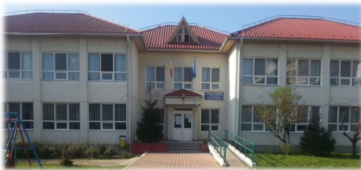
Complexul de servicii alternative la protecția copilului a fost dotat cu panouri termosolare
