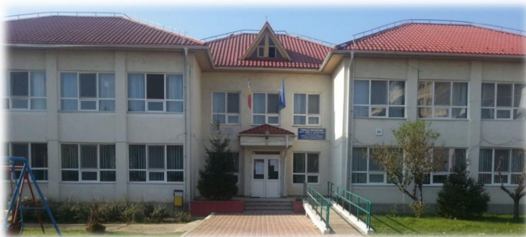
Fig. 2.101. Complexul de servicii alternative la protecția copilului a fost dotat cu panouri termosolare
