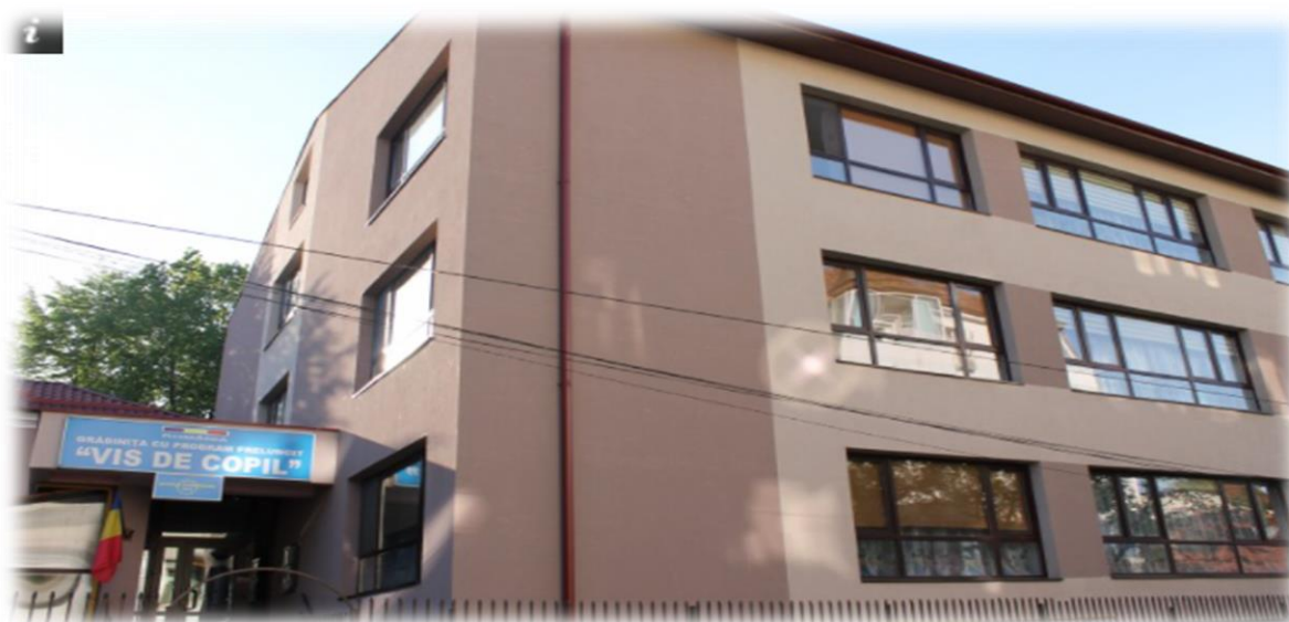
Grădinița Vis de copil clădire reabilitată și dotată cu panouri termosolare
