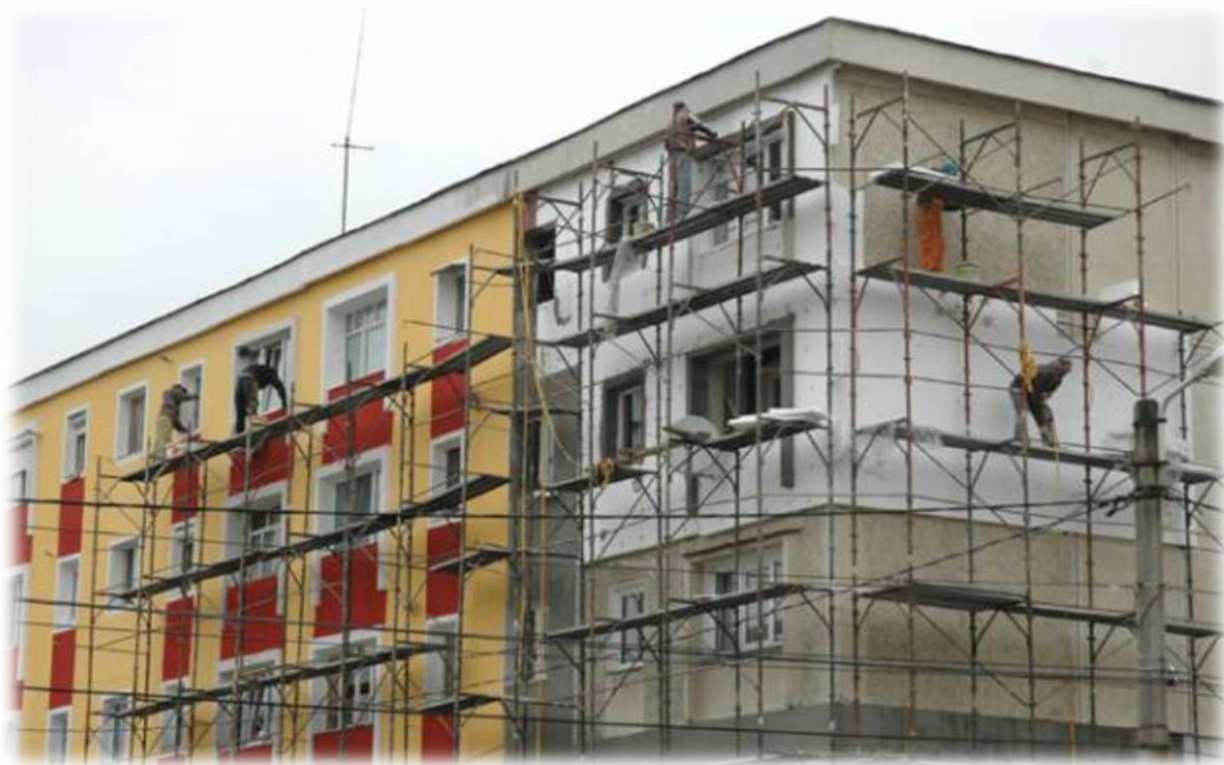
Șantier de reabilitare termică a unui bloc din Municipiul Tg Jiu
