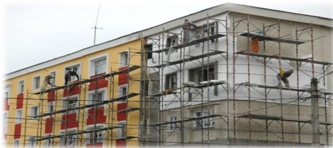
Fig. 2.96. Șantier de reabilitare termică a unui bloc din Municipiul Tg Jiu
